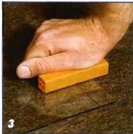
3 Варианты применения бруска-стеклолома при вырезании стекла.
