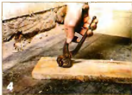
Гвозди из плинтуса вытаскивают клещами с внутренней стороны.
