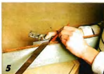
Линии резания для запиливания плинтуса «на ус» наносят с помощью столярного угольника. Для контроля направления резания линию наносят и на верхнюю кромку заготовки.
